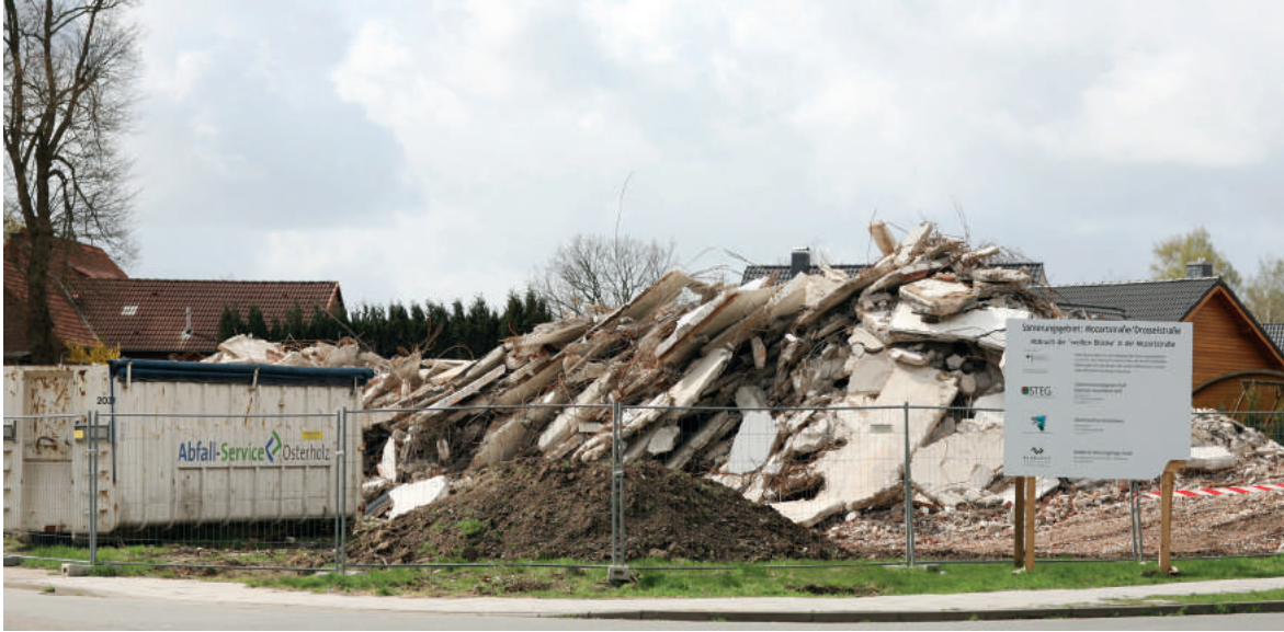
Sanierung der Mozartstraße
