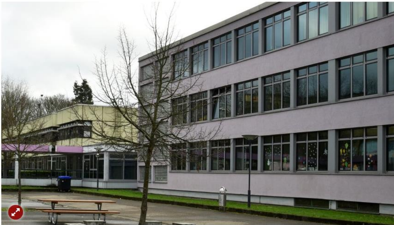
Gemeinschaftsschule Bruchwiese in Saarbrücken
